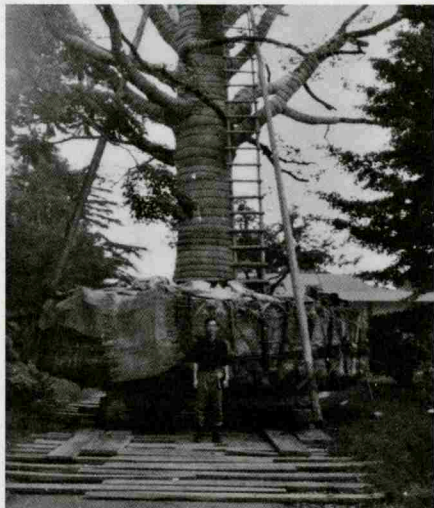
図4 イチョウの立曳き運搬 (昭和40年撮影被写体：筆者)
